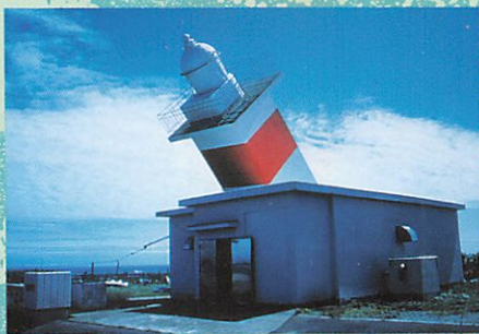
図4 倒壊した奥尻町青苗岬灯台 平成6年1月現在は仮設灯台がこの横に設置されているが、4月には高さ14 m、光到達距離29kmの新灯台が完成する予定である
