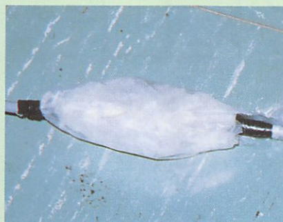
図21 ジョイント部をビニールで被覆した状態
